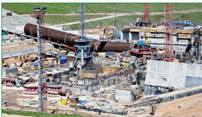
Начало строительства Загорской ГАЭС-2
