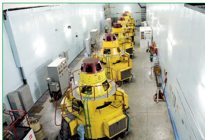
Электрогенераторы-двигатели в машинном зале Кубанской ГАЭС
