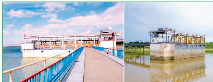
Здание Кубанской ГАЭС при максимуме (слева) и минимуме воды в водохранилище
