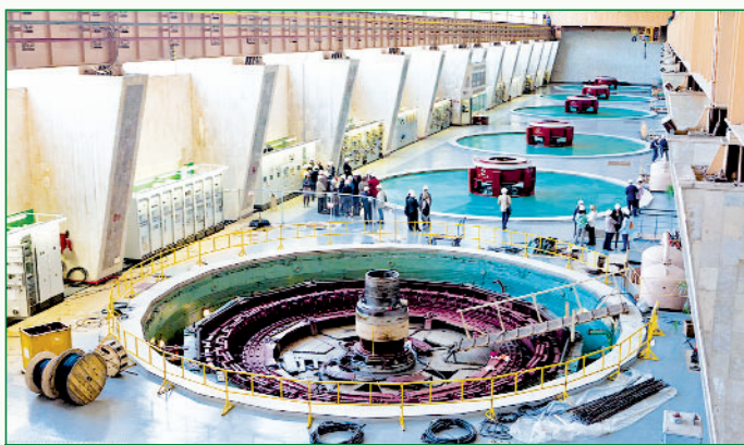
Монтаж последнего агрегата Загорской ГАЭС
