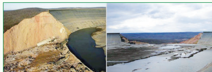
Разрушение дамбы ГАЭС "Таум Саук"
