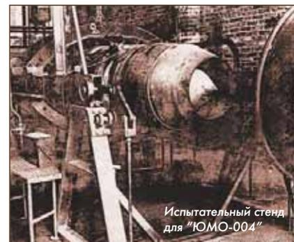
Испытательный стенд для "ЮМО-004"
