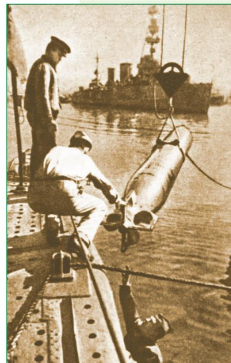
Погрузка торпеды на подводную лодку
