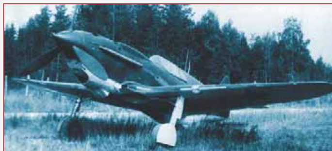
Истребитель ЛаГГ-3 с пушкой ШВАК, пулеметом БС и двумя пулеметами ШКАС
