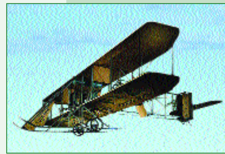
Аэроплан братьев Райт оснащался ДВС
