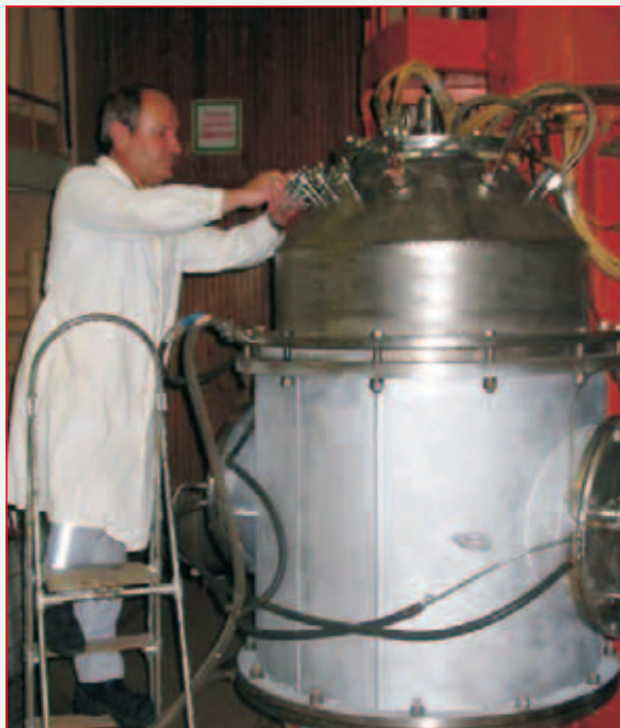
Монтаж теплового аккумулятора в вакуумной камере
