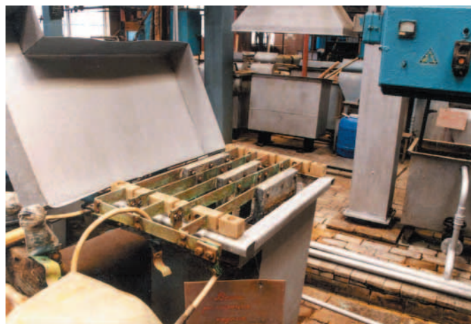
Установка электроэкстракции кадмия
