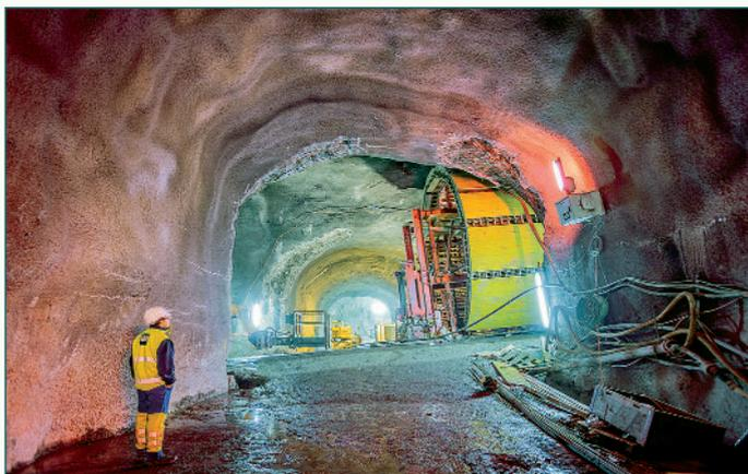
ГАЭС Nant de Drance - установка напорного водовода
