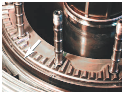
Место проверки радиального зазора между лабиринтами вала газогенератора и сотовым уплотнением СА ТВД
