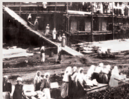
Подавляющее большинство строителей завода в 1916 г. составляли женщины
