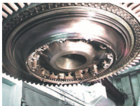
Подготовка соплового аппарата ТНД к монтажу ротора турбины низкого давления
